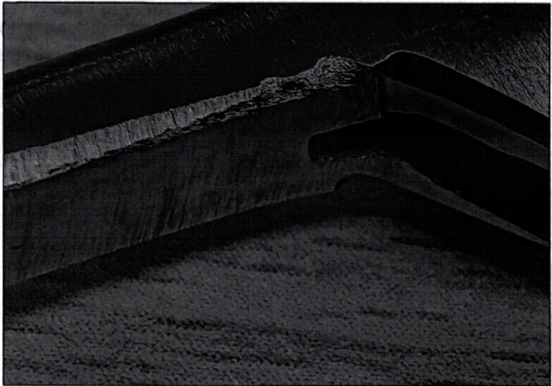
Фотографическое изображение 11 Дефекты поверхностей 3 (крупный план)
